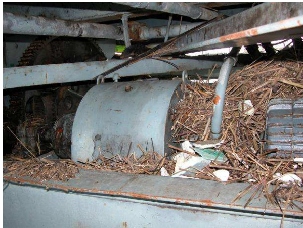
Chef Menteur Pass Bridge: Submerged gear box
